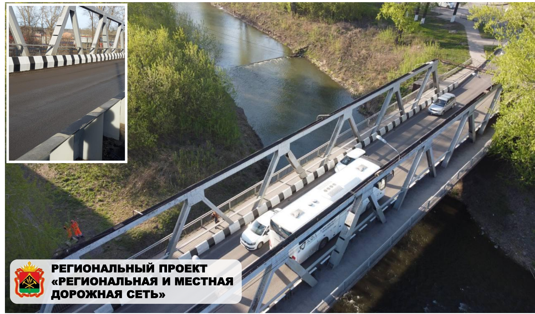
АВТОДОРОЖНЫЙ МОСТ ЧЕРЕЗ Р. АБА ПО УЛИЦЕ 1 МАЯ
